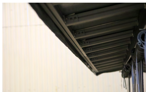
*6 - Vrid den ihopsatta baldakin-stängens (nr 10A och nr 10B) 90 grader in mot tältet.
