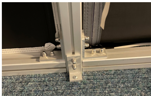
*4 - Nu ska du fästa B-vinklar på de redan monterade bultbrickorna längst ner på samtliga profiler. När B-vinklarna är på plats och tältet står i sin rätta position sätter du fast tältet med trä- eller trallskruv.
