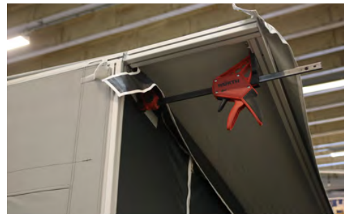
*7 - Spänn upp yttertaket på utsidan genom att tvinga ut de yttre takstolarna både vid front- och bakväggen.
